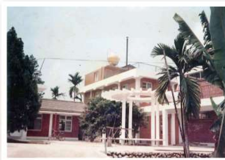
感恩樓完成增建2樓後照片-2
